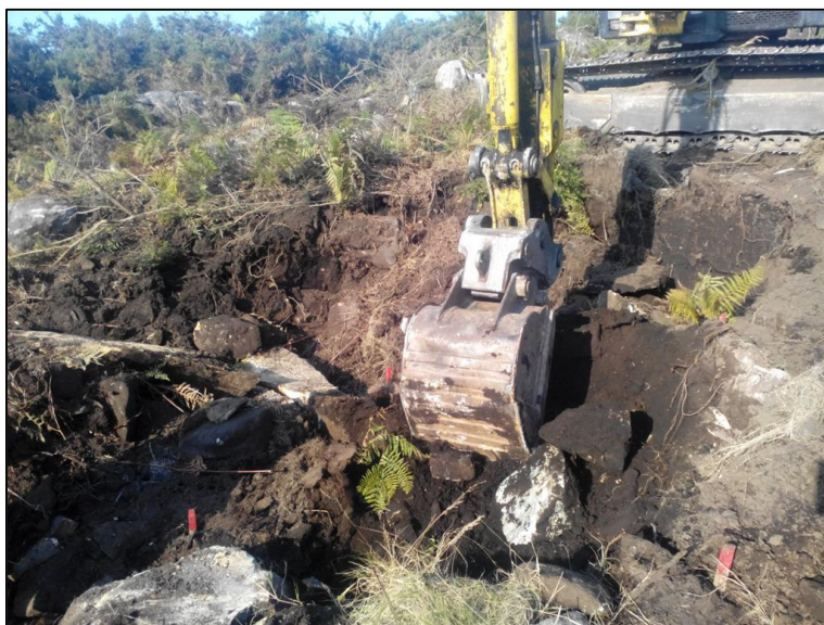
Foto 12 - Trabalhos de escavação no P38
