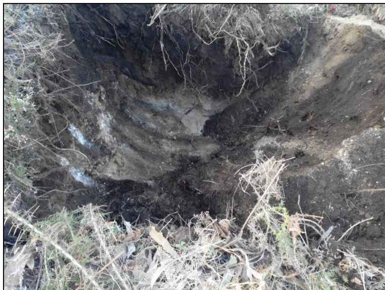
Foto 17 – Abertura de acesso ao P71
