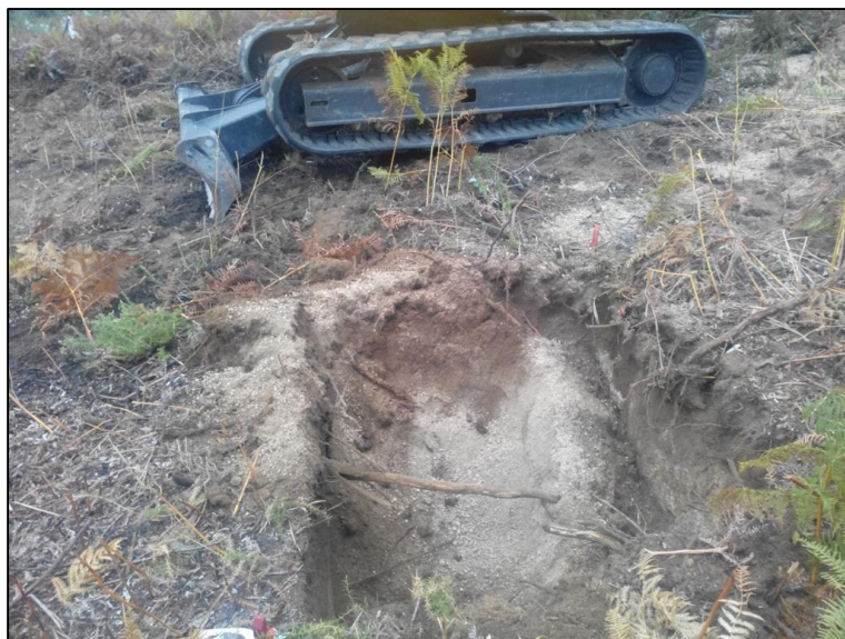
Foto 8 - Trabalhos de escavação no P77
