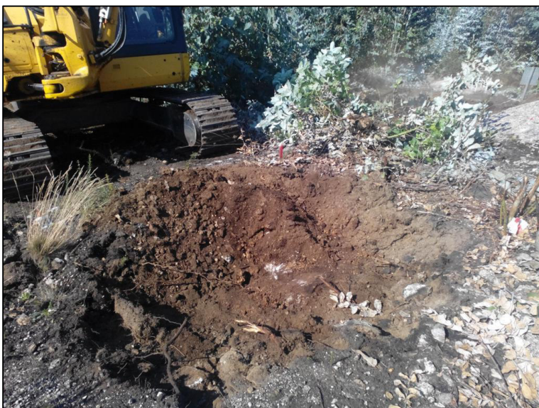
Foto 6 – Trabalhos de escavação no P64
