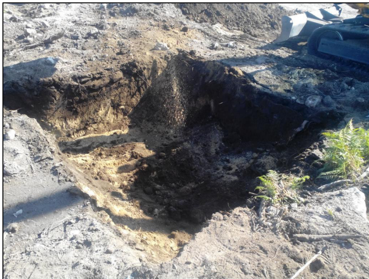
Foto 13 – Trabalhos de escavação no P78
