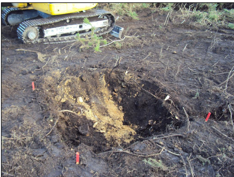
Foto 5 – Trabalhos de escavação no P76
