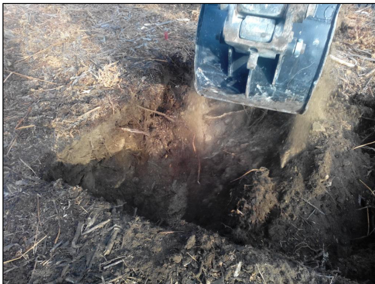
Foto 15 – Trabalhos de escavação no P74
