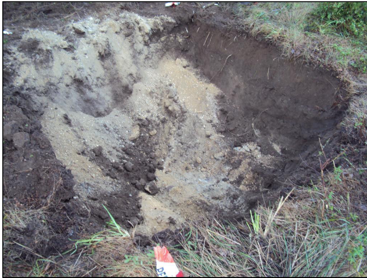
Foto 3 – Trabalhos de escavação no P54
