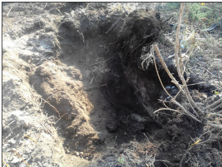
Foto 16 – Trabalhos de escavação no P71
