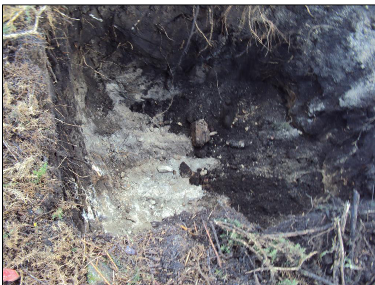
Foto 2 – Trabalhos de escavação no P41
