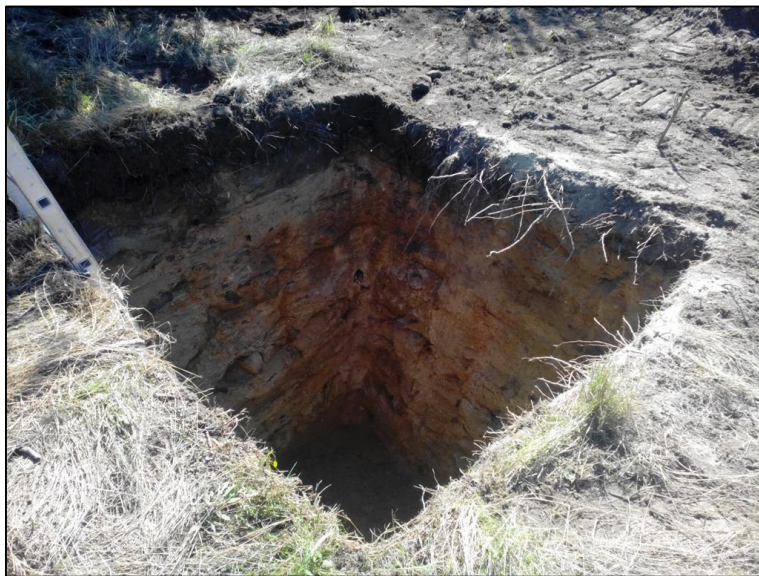
Foto 11 - Trabalhos de escavação no P34
