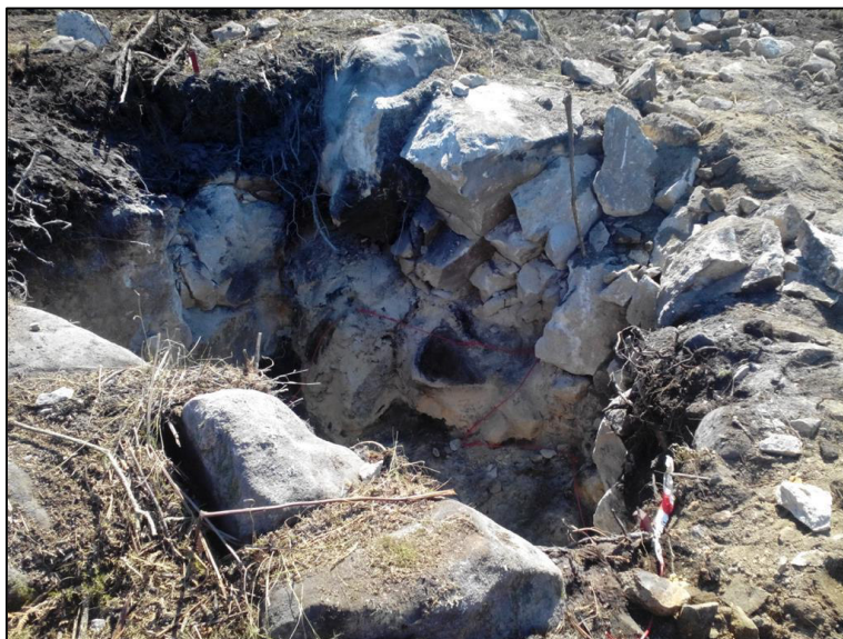
Foto 14 – Trabalhos de escavação no P59
