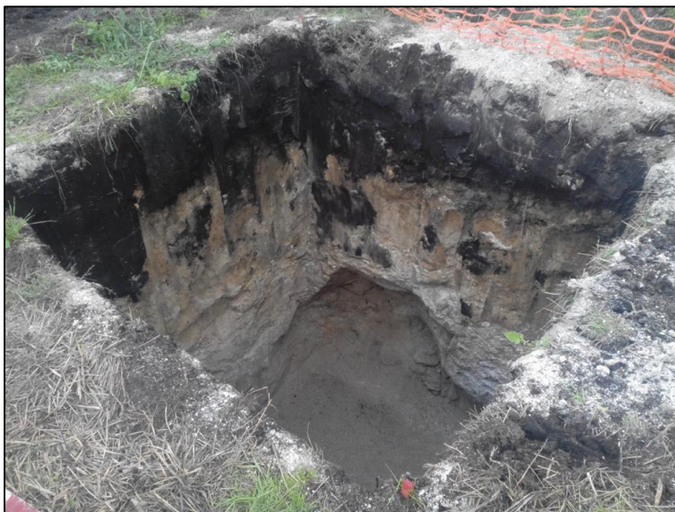
Foto 1 – Trabalhos de escavação no P37
