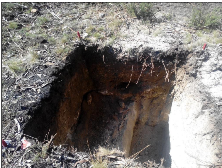
Foto 9 - Trabalhos de escavação no P65
